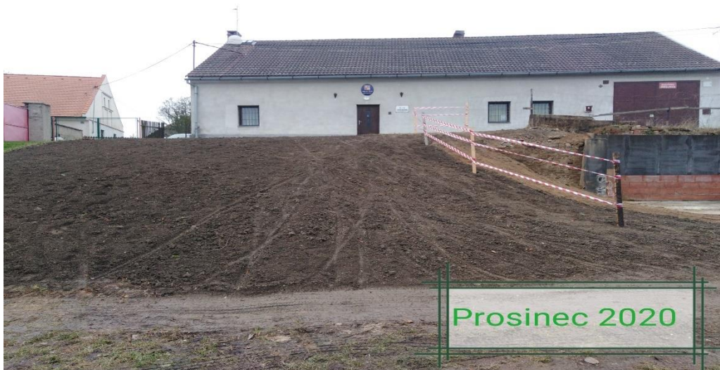
FOTO PO DEMOLICI
