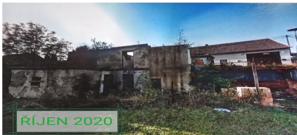
FOTO PŘED DEMOLICÍ
